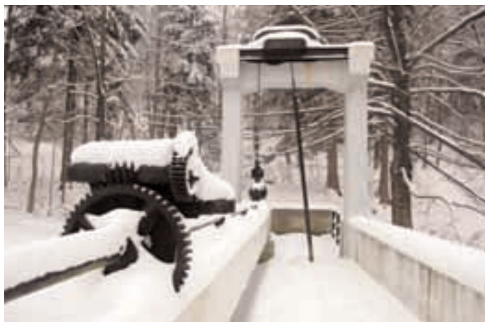
Obr. 15. Liberec-Rudolfov, automatický klapkový uzávěr s protizávažím na hrázi vyrovnávací nádrže, v pozadí zídka s pamětním kamenem stavby. (Foto: Petr Freiwillich, 2013)
